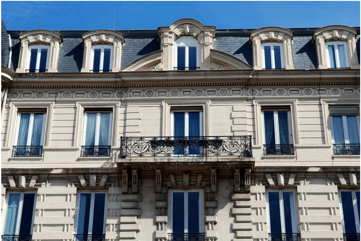
Détail de la travée axiale
