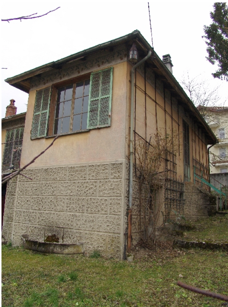
Façades de l'aile droite
