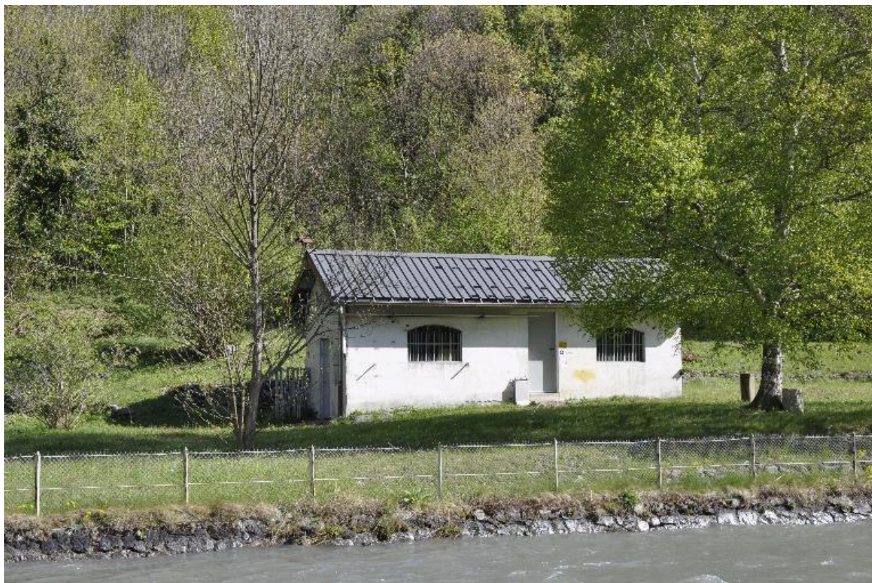
Annexe du barrage
