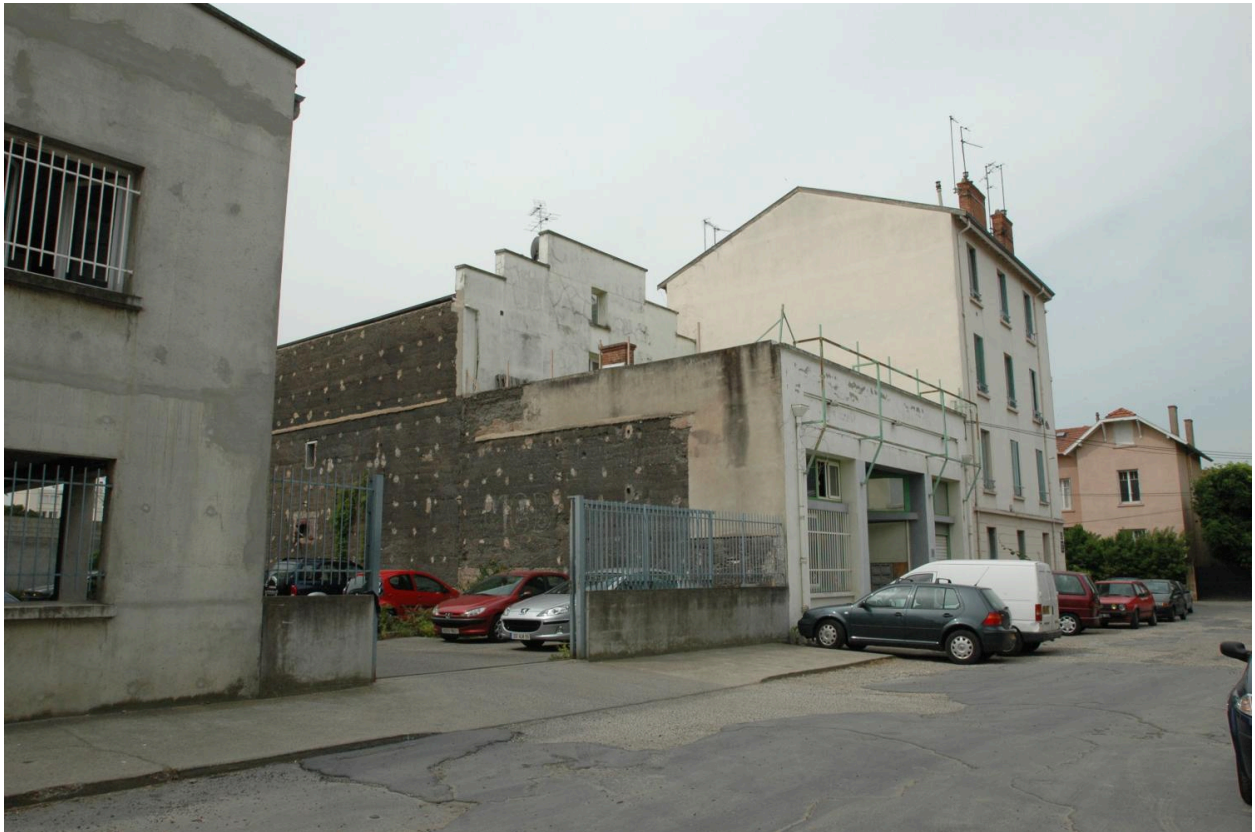
Façade nord impasse Morel
