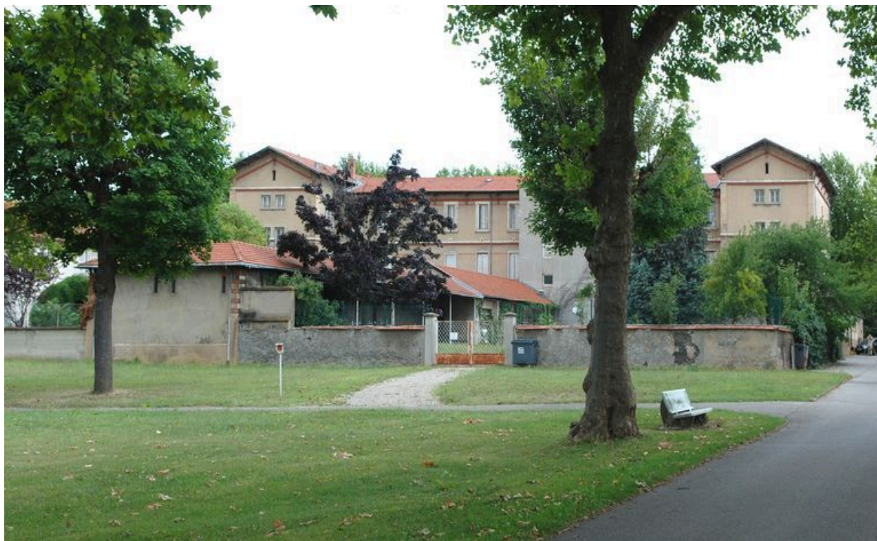
Vue d'ensemble, façade postérieure
