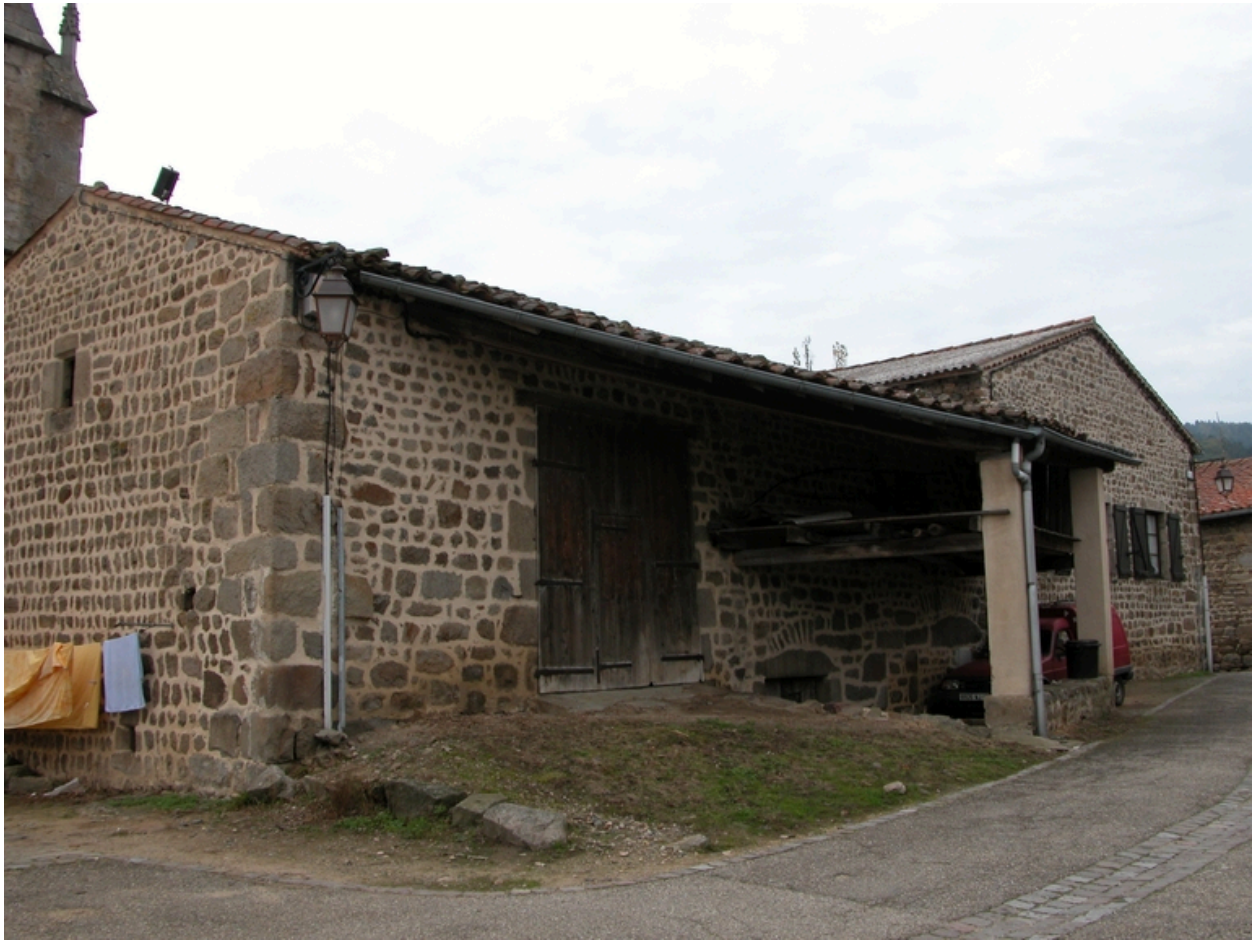
Vue de la grange-étable, depuis le nord-est.
