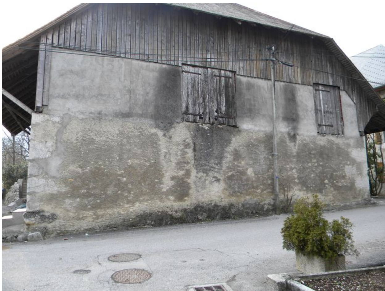
Mur pignon de la dépendance agricole sud.
