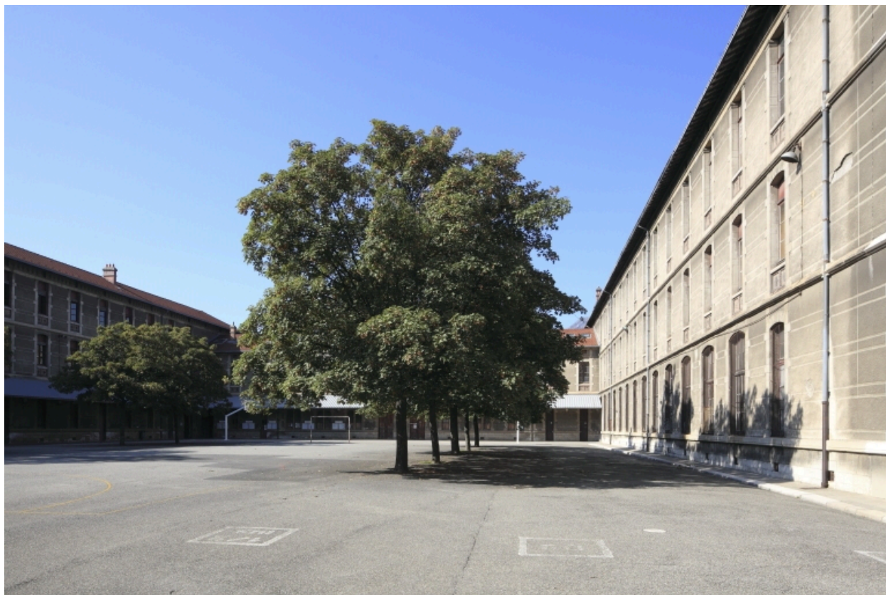
Cour C. Vue d'ensemble.
