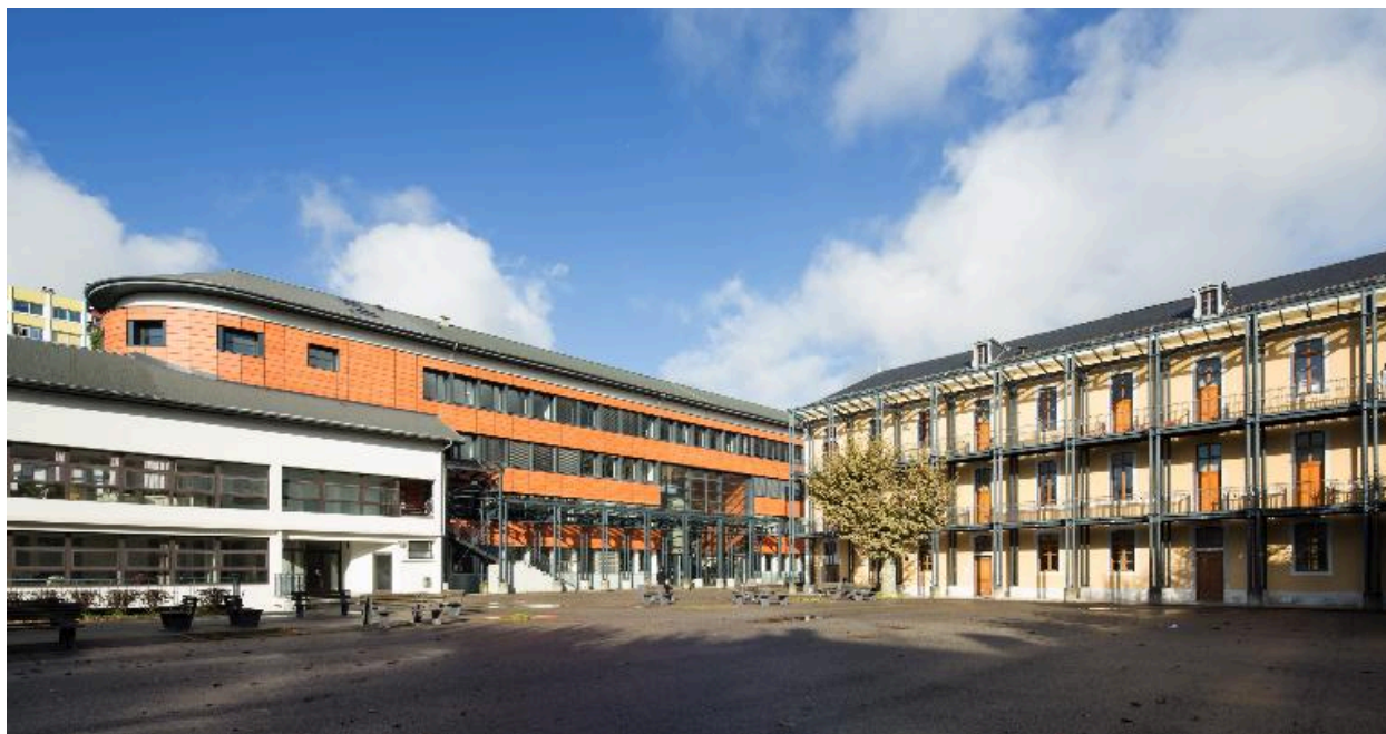
Cour 3 : vue vers le nord-ouest : bâtiment 19e, aile Brogny et CDI.
