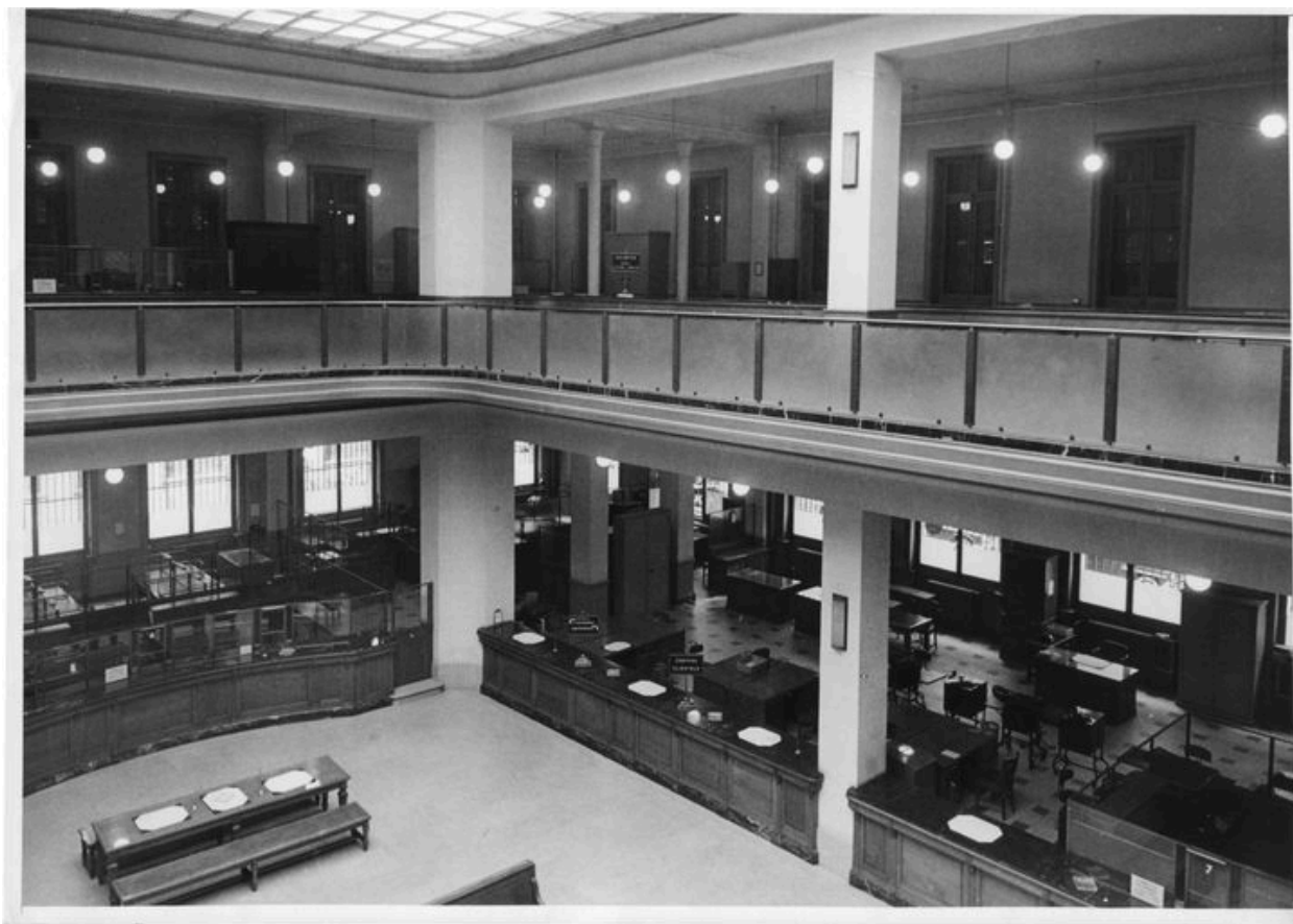
Vue du hall du public et des services (la verrière a été remontée d'un niveau) en 1959-1960 (Banque de France, archives historiques, 1Fi 0497-16, photographie).
