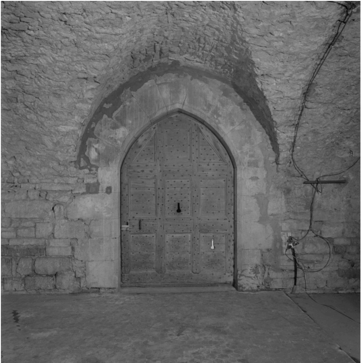
Porte en arc brisé, située sous la terrasse actuelle et ouvrant sur l'étage de soubassement.
