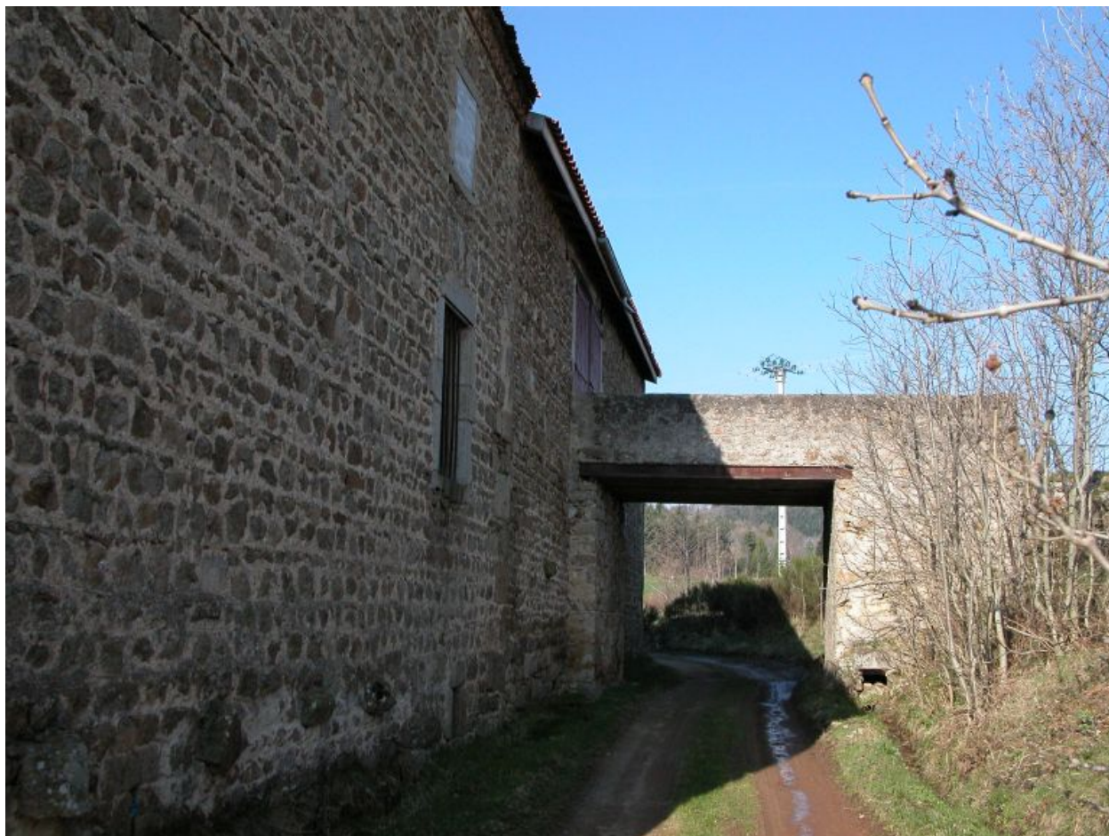
Vue arrière de la grange-étable, avec montoir (pente maçonnée).
