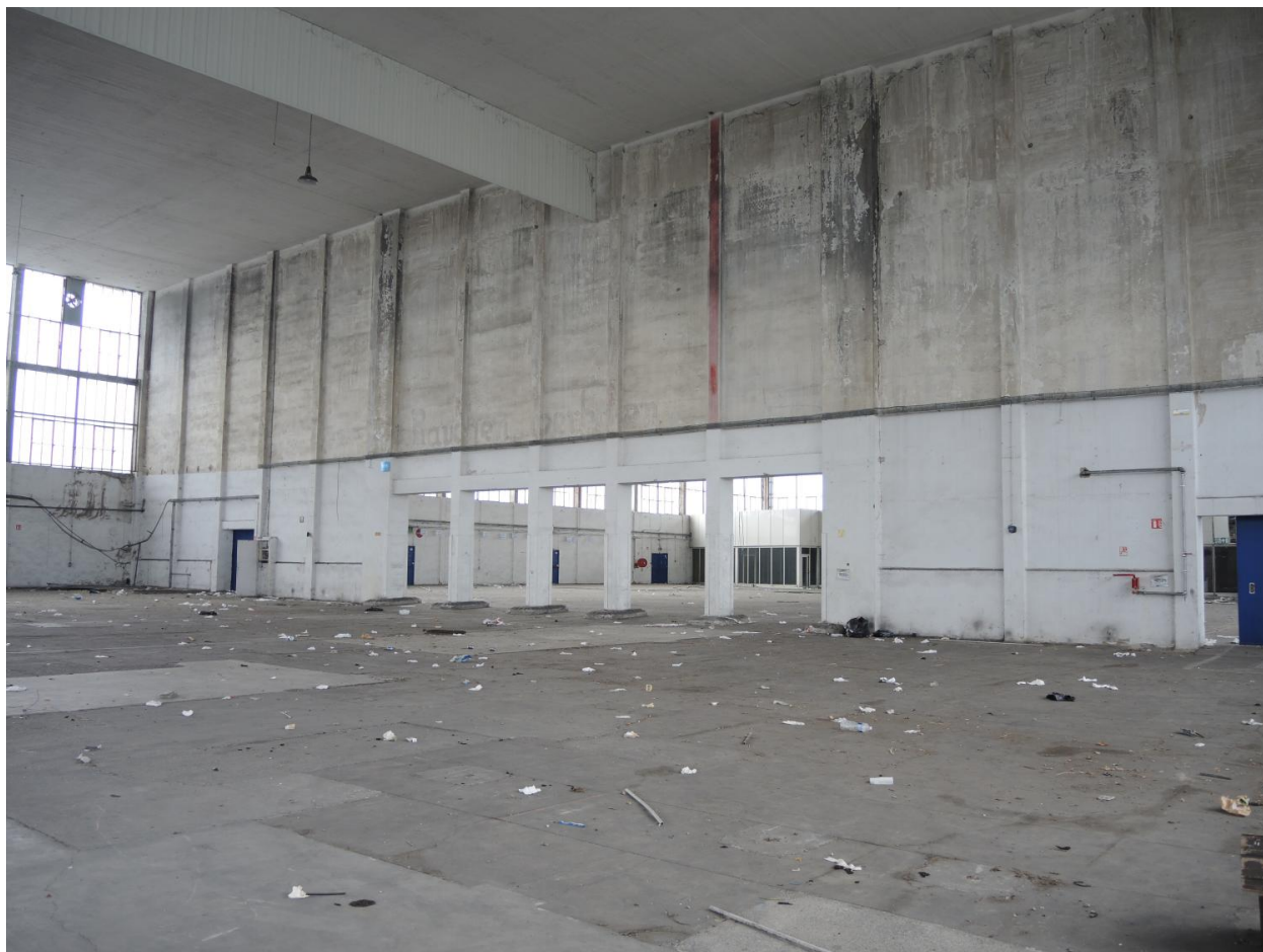
Hangar VI photo vue d'intérieur
