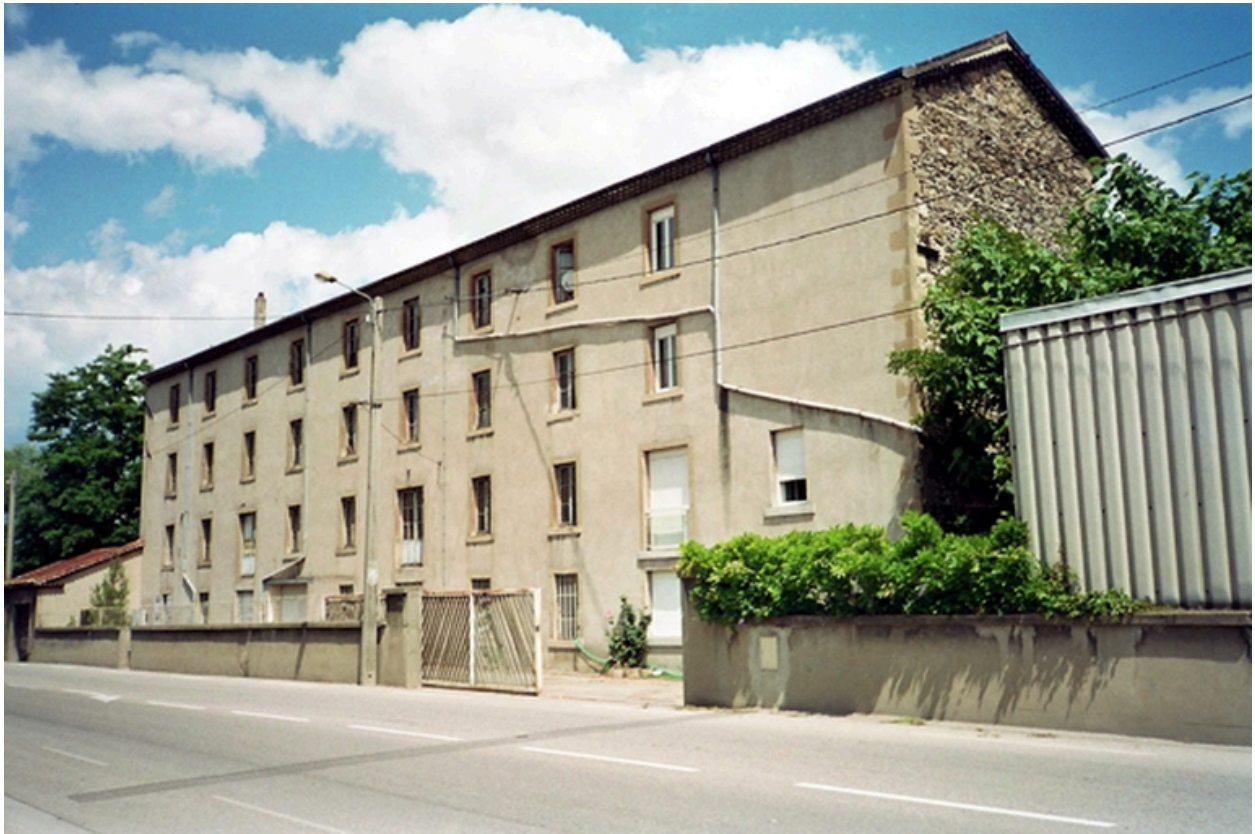
Façade principale sud
