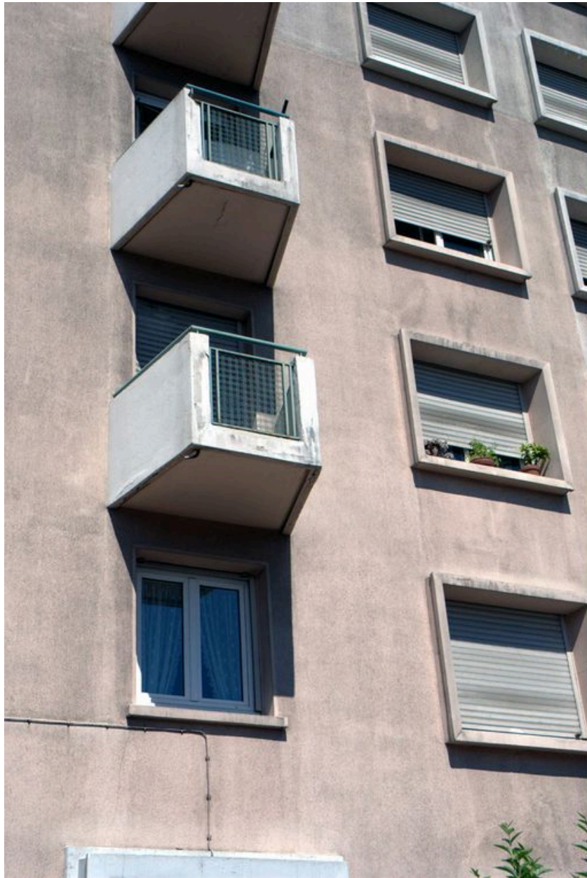
N°66, détail de la travée centrale
