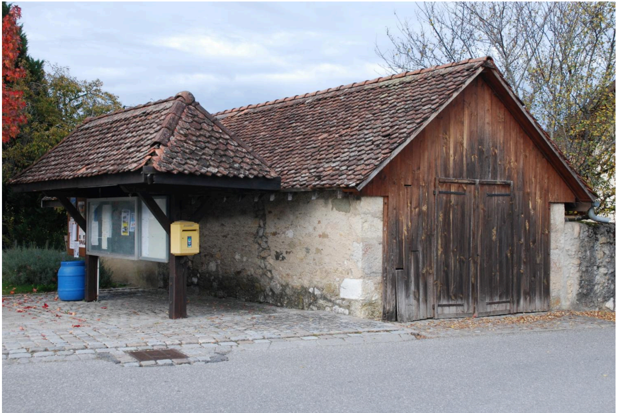
Vue du four à pain.
