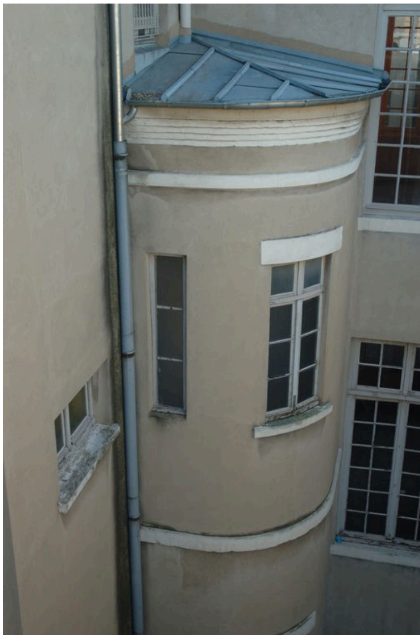
Détail de l'ancien bâtiment des malades (élévation ouest), en octobre 2011.
