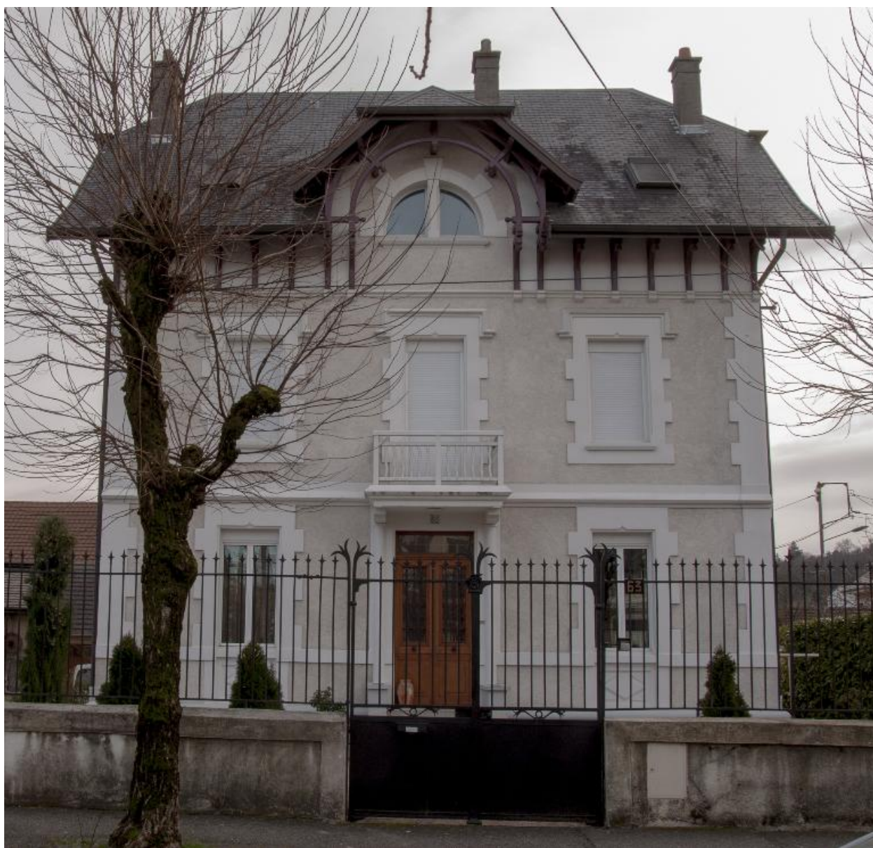
Façade principale (nord)
