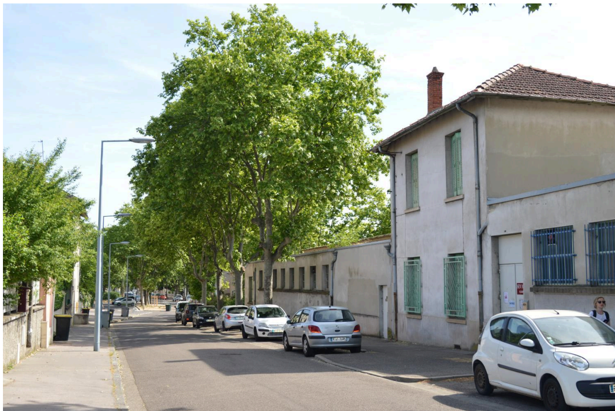
Façade principale des bains douches de Vénissieux avec maison du gardien
