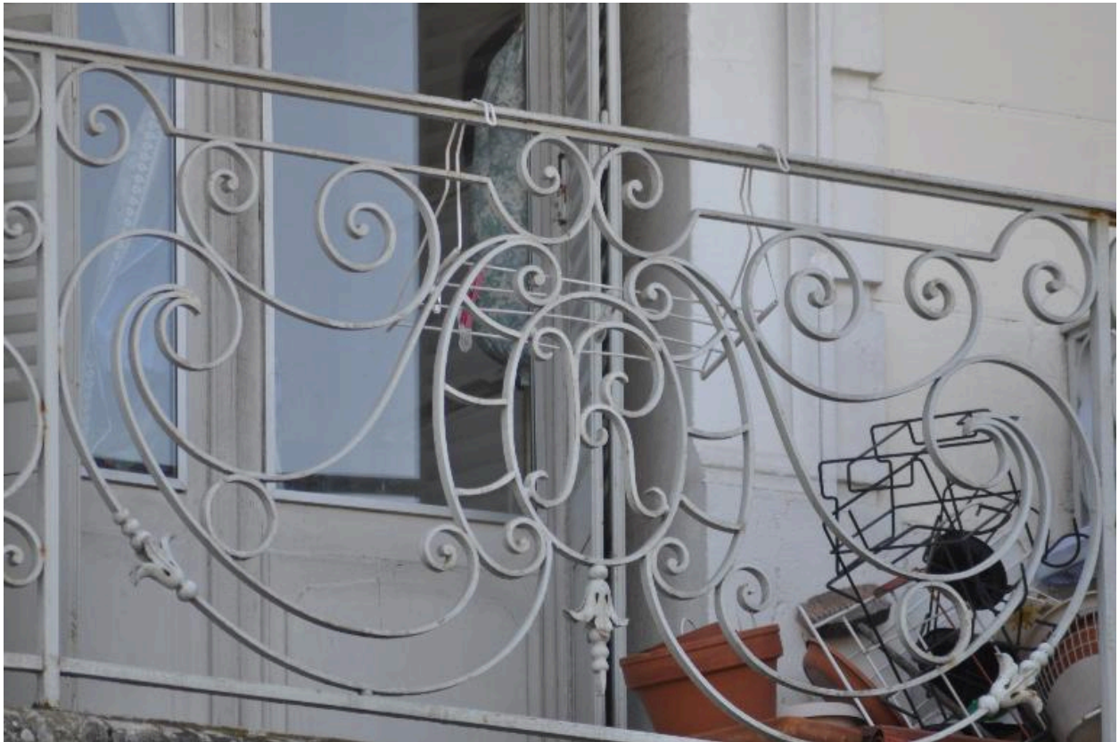
Lettre R dans la ferronnerie d'un garde-corps
