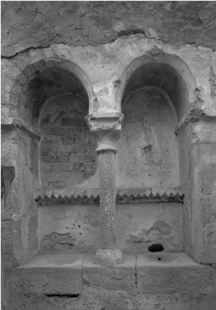
Lavabo situé dans le mur sud de l'abside.
