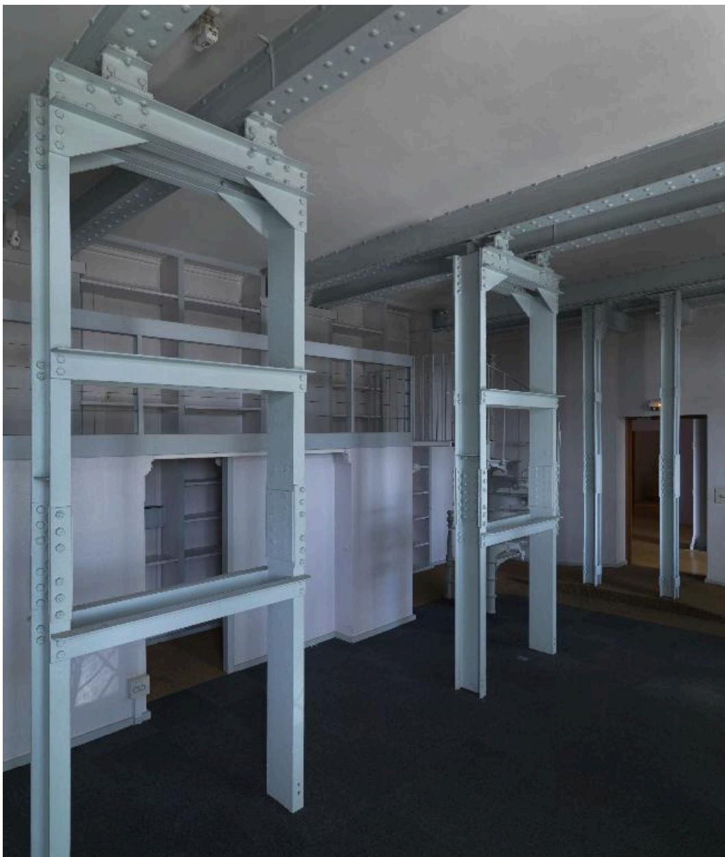
Vue intérieure de l'ancien réfectoire, avec les chevlements métalliques installés en 1937
