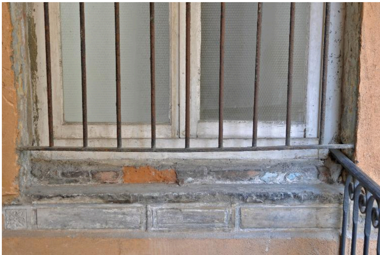
Détail d'un appui de fenêtre, dans la cage d'escalier
