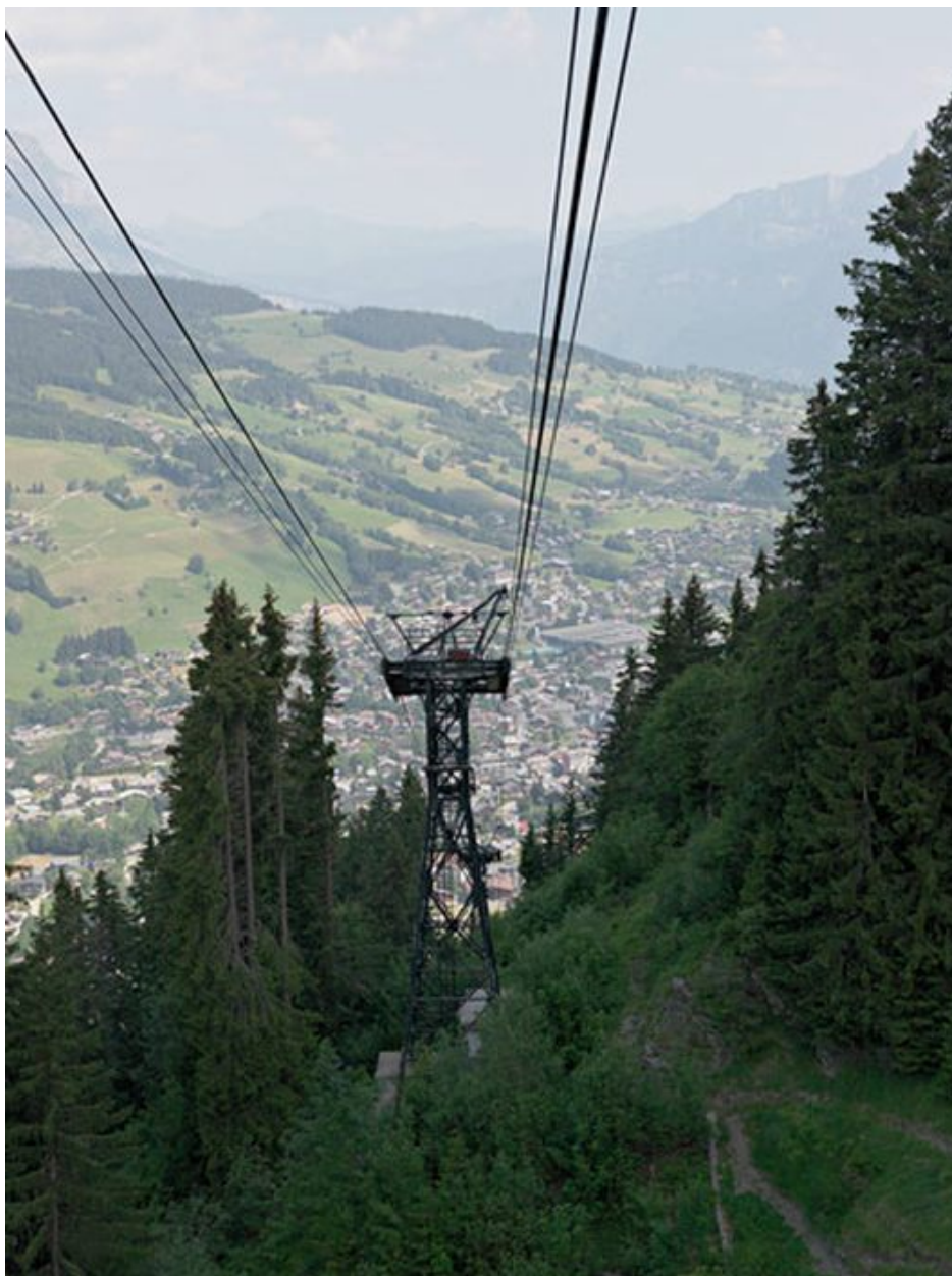
Le pylône supérieur depuis l'amont
