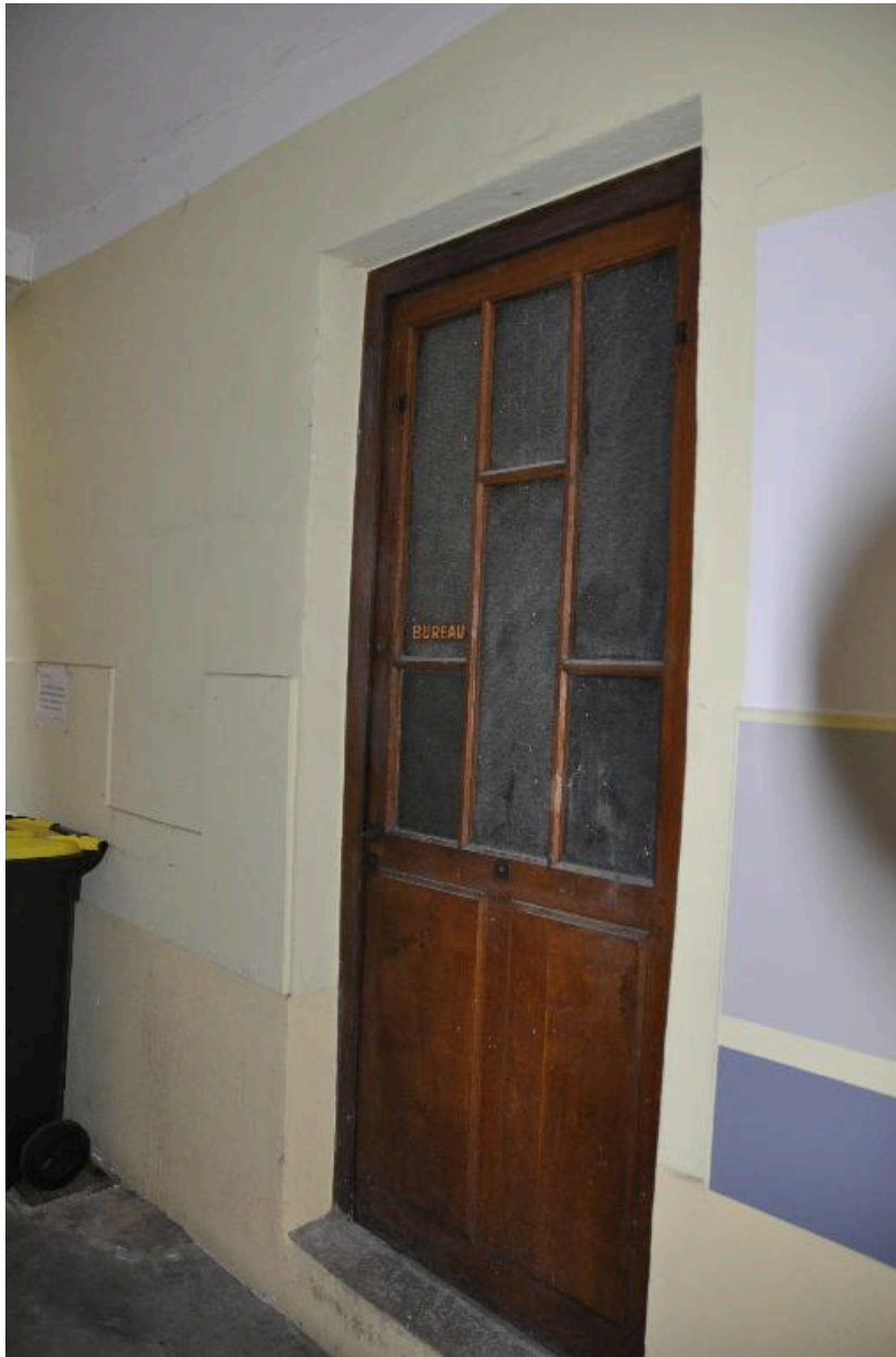
Vue du rez-de-chaussée du deuxième corps de logis
