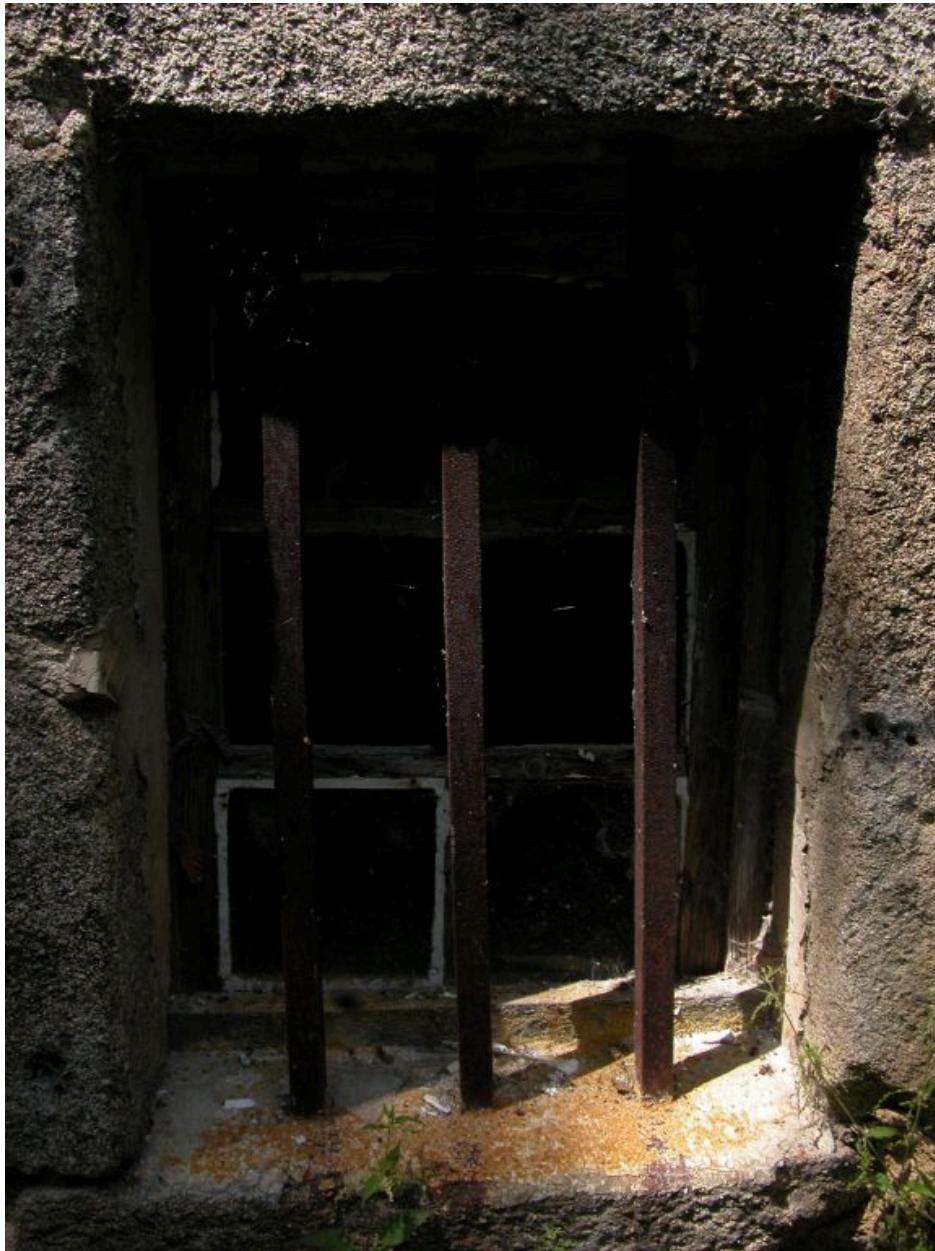
Mur gouttereau sud, détail fenêtre du logis.
