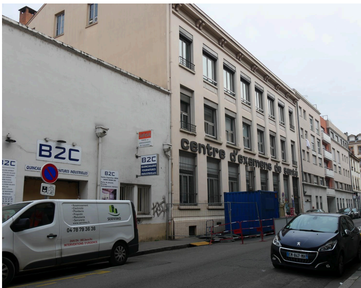
vue d'ensemble façade
