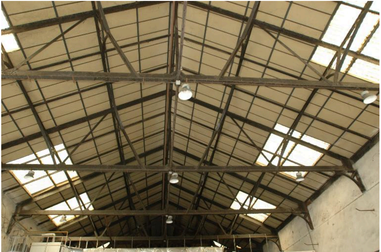
Vue de la charpente métallique des ateliers
