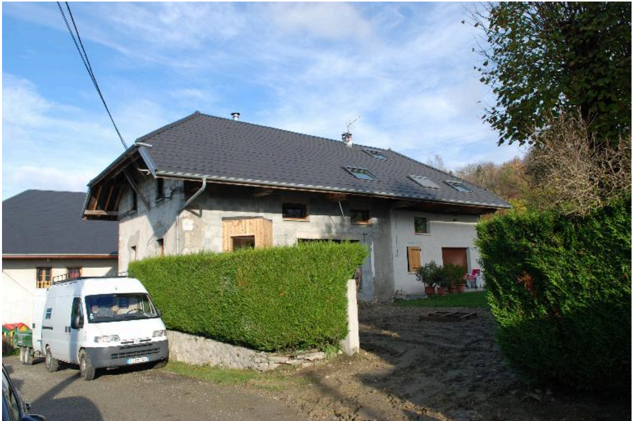
Exertier (les), ferme 2014 B3 414. Vue d'ensemble de la façade principale.
