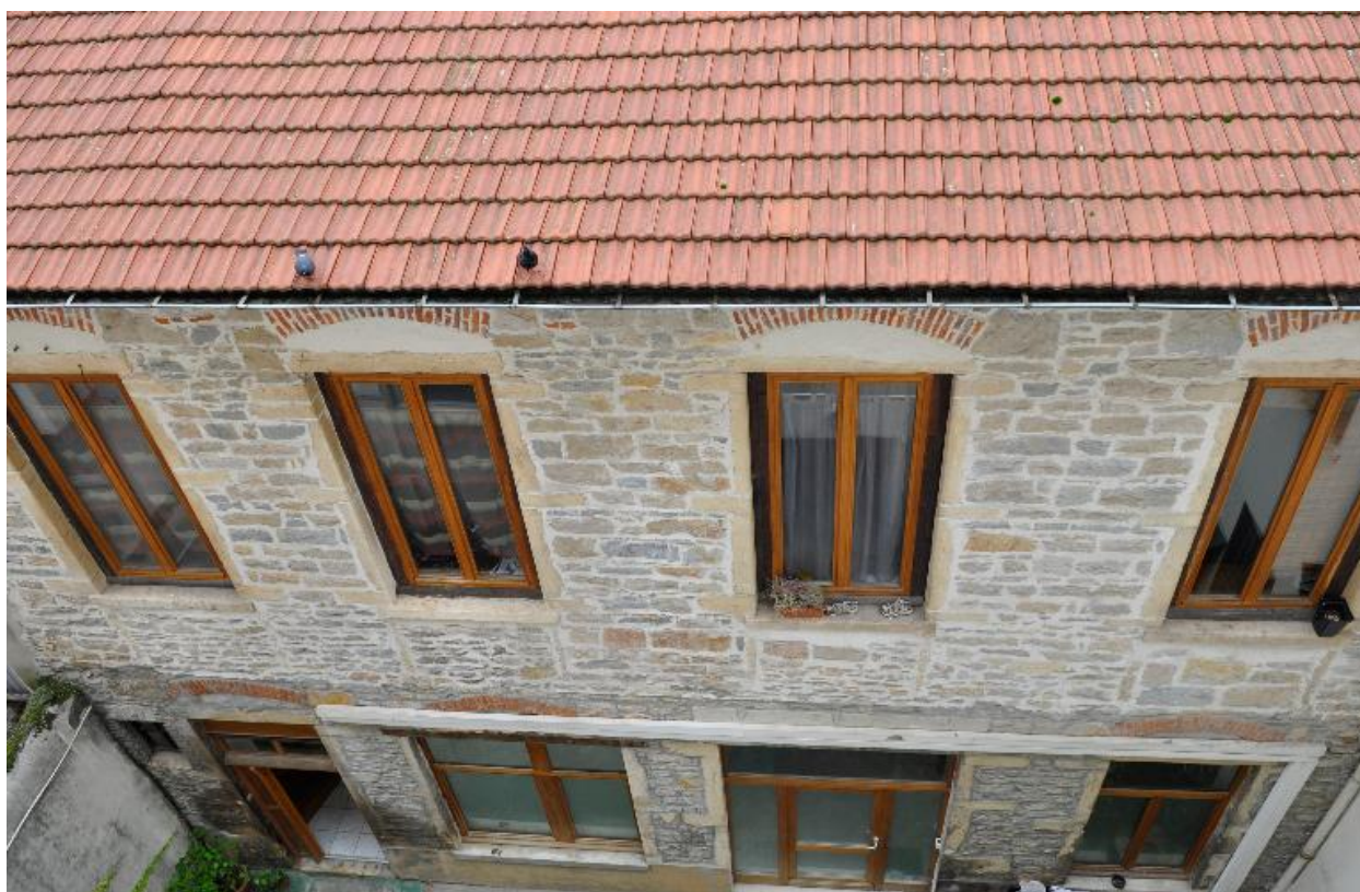
Immeuble sur cour, élévation en moellons apparents
