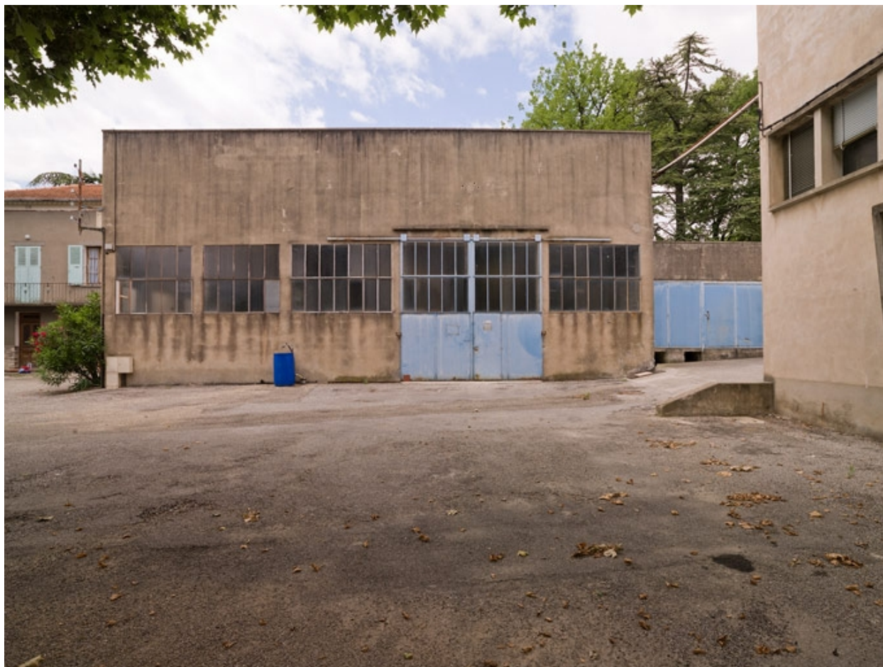
Vue d'ensemble nord du site
