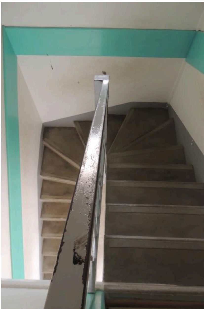
Escalier du bâtiment secondaire.
