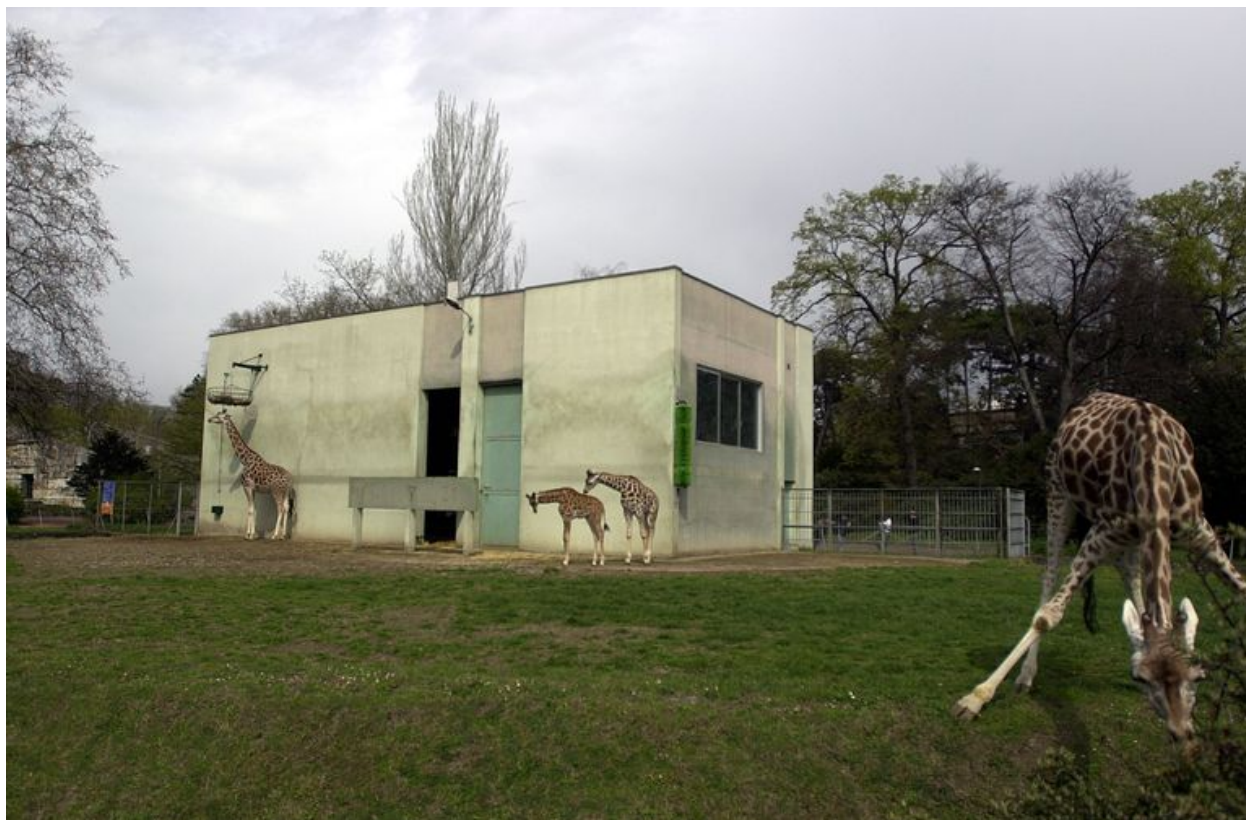
Le pavillon des girafes : vue générale
