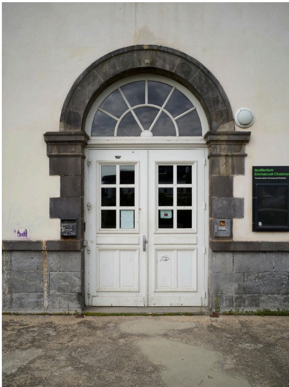
Elévation latérale est : détail d'une porte d'entrée (face escalier D)
