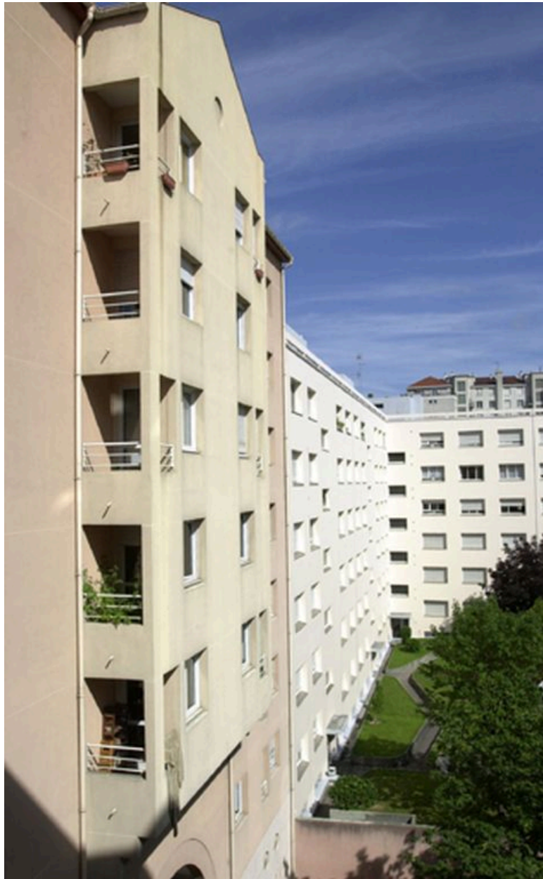
Elévation postérieure depuis le 16 rue Sébastien-Gryphe
