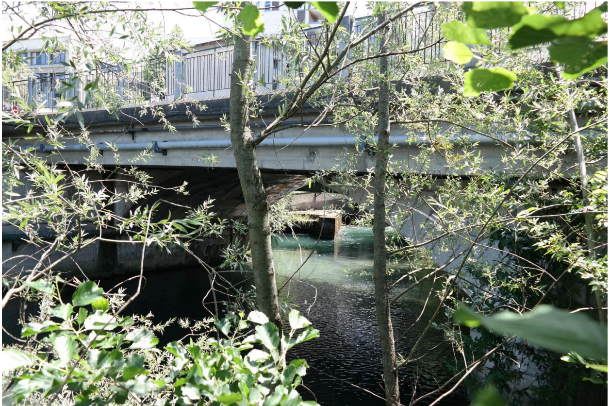
Pont de Cran, vue de la face aval
