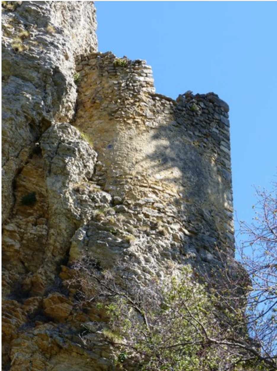
Vue d'ensemble prise du nord-ouest.
