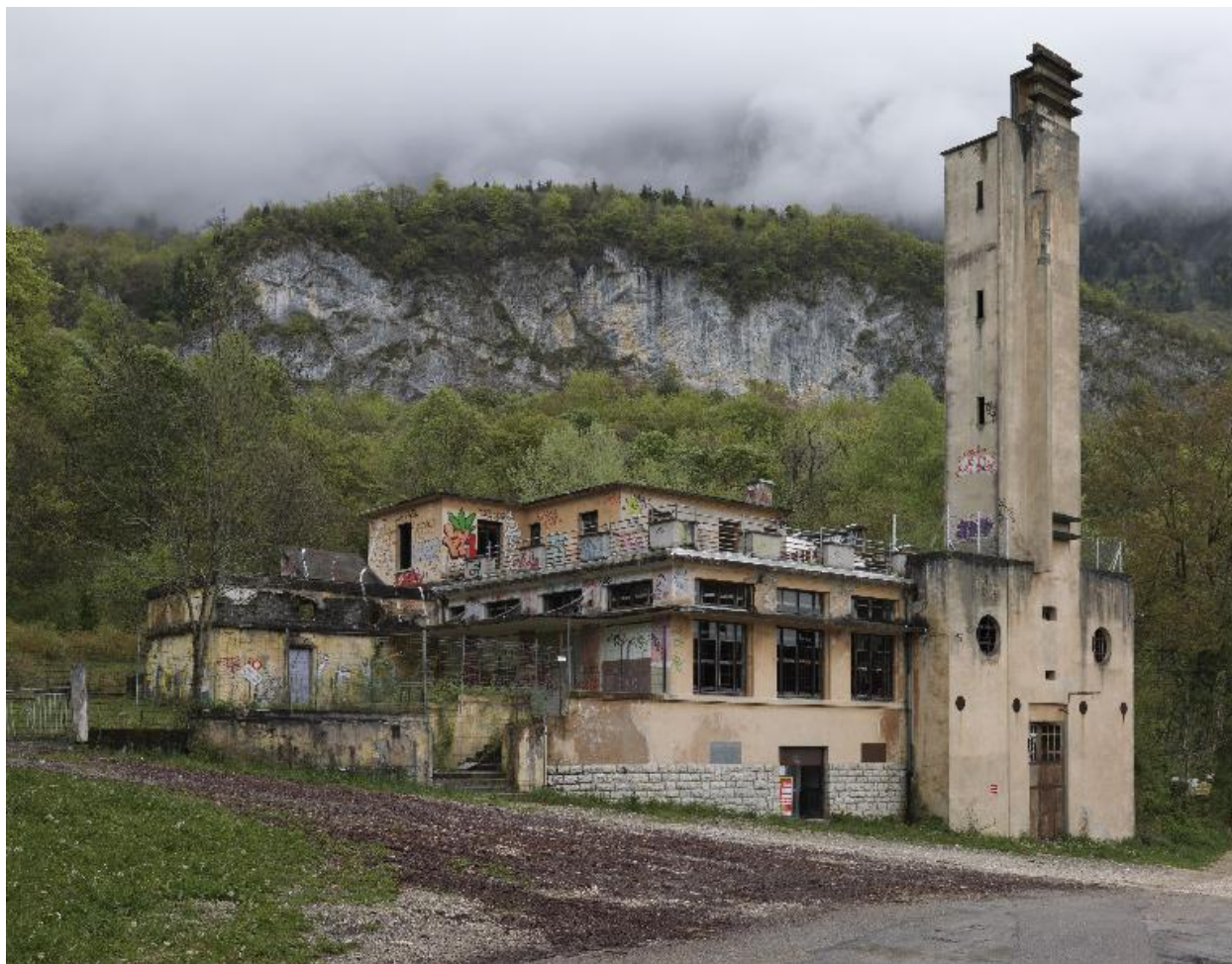
Vue d'ensemble : façades nord et ouest
