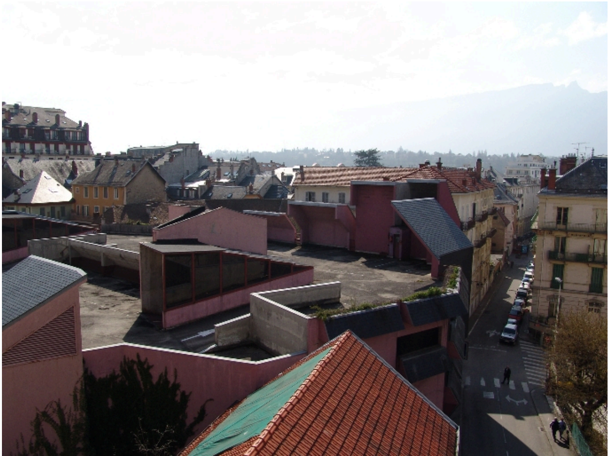
Vue des toits
