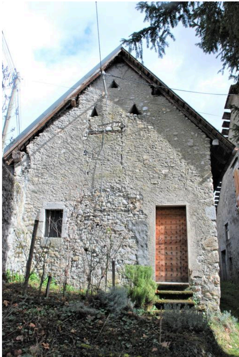
Bâtiment abritant les communs (étables, granges). Elévation du mur pignon ouest.
