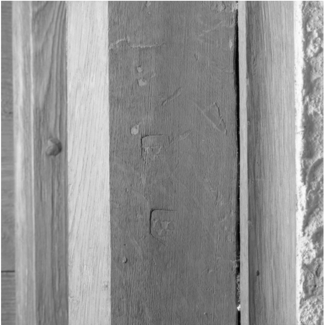
Logis prieural, salle du premier étage : détail de la marque du "marteau à frapper" des Urfé dans le chambranle de la porte des latrines.
