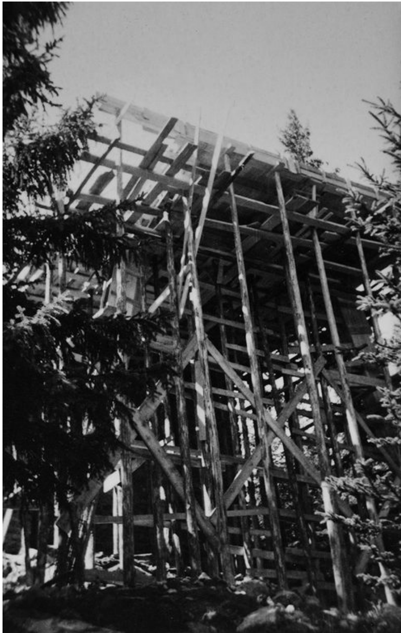
Le chalet en construction. Photogr. Denys Pradelle, [1950] (AD Savoie. 6J 100)
