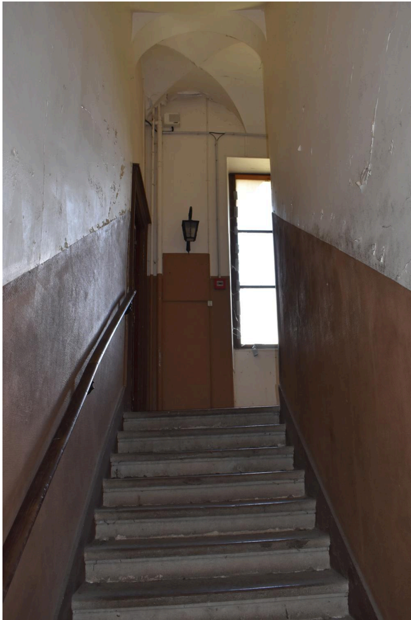
Escalier, palier voûté d'arêtes
