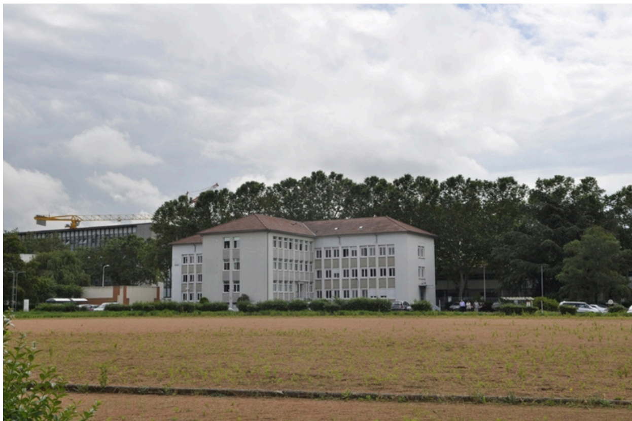
Bâtiment administratif daté des années 70.
