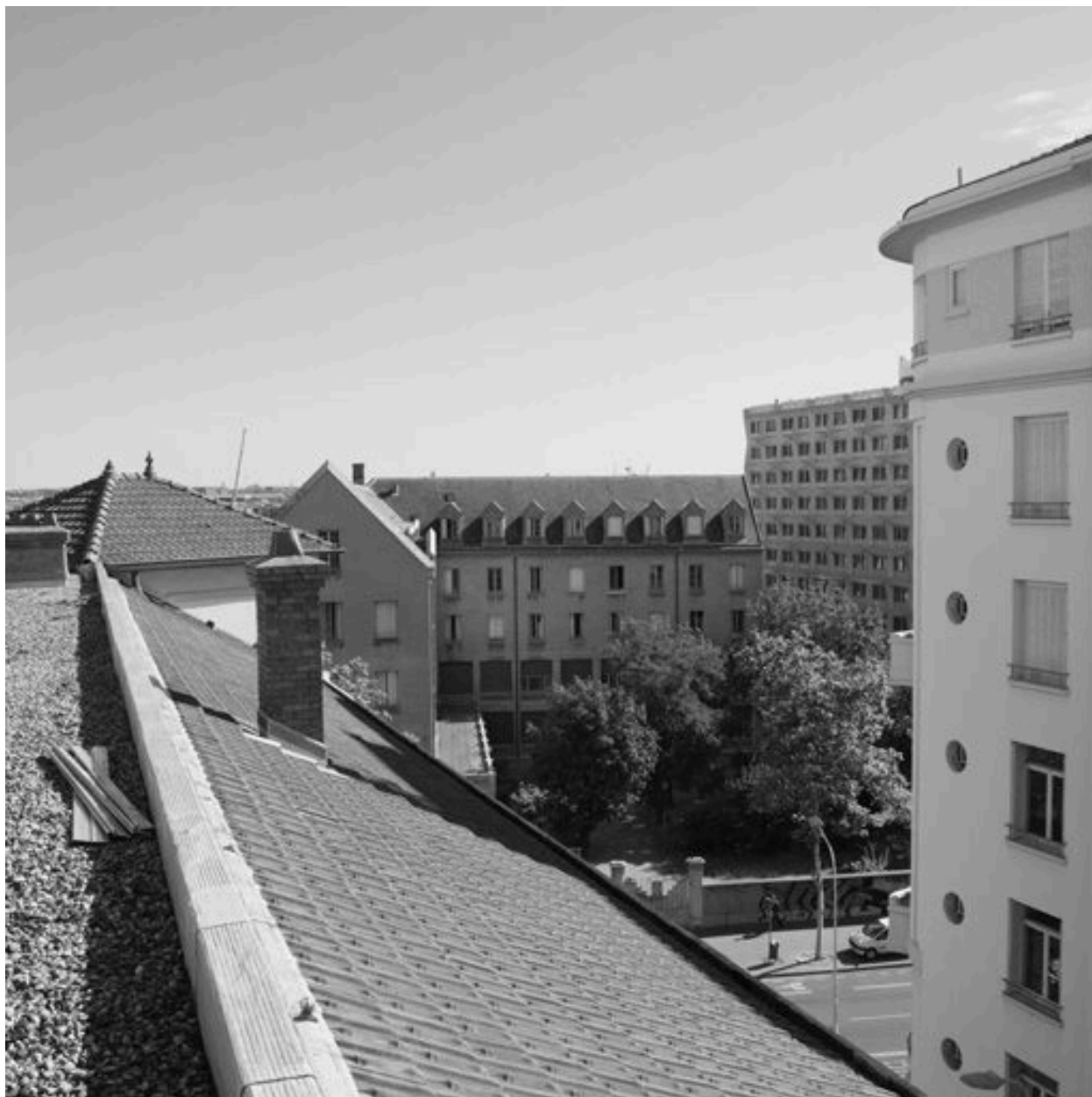
Détail des toits du corps de bâtiment est
