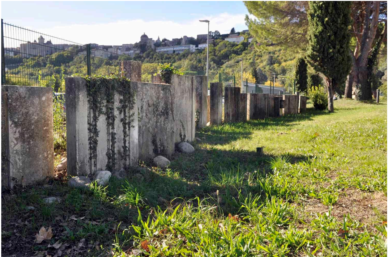
Partie sud : vue d'ensemble côté ouest
