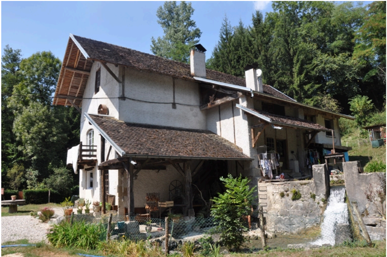
Vue façade est avec la réserve d'eau
