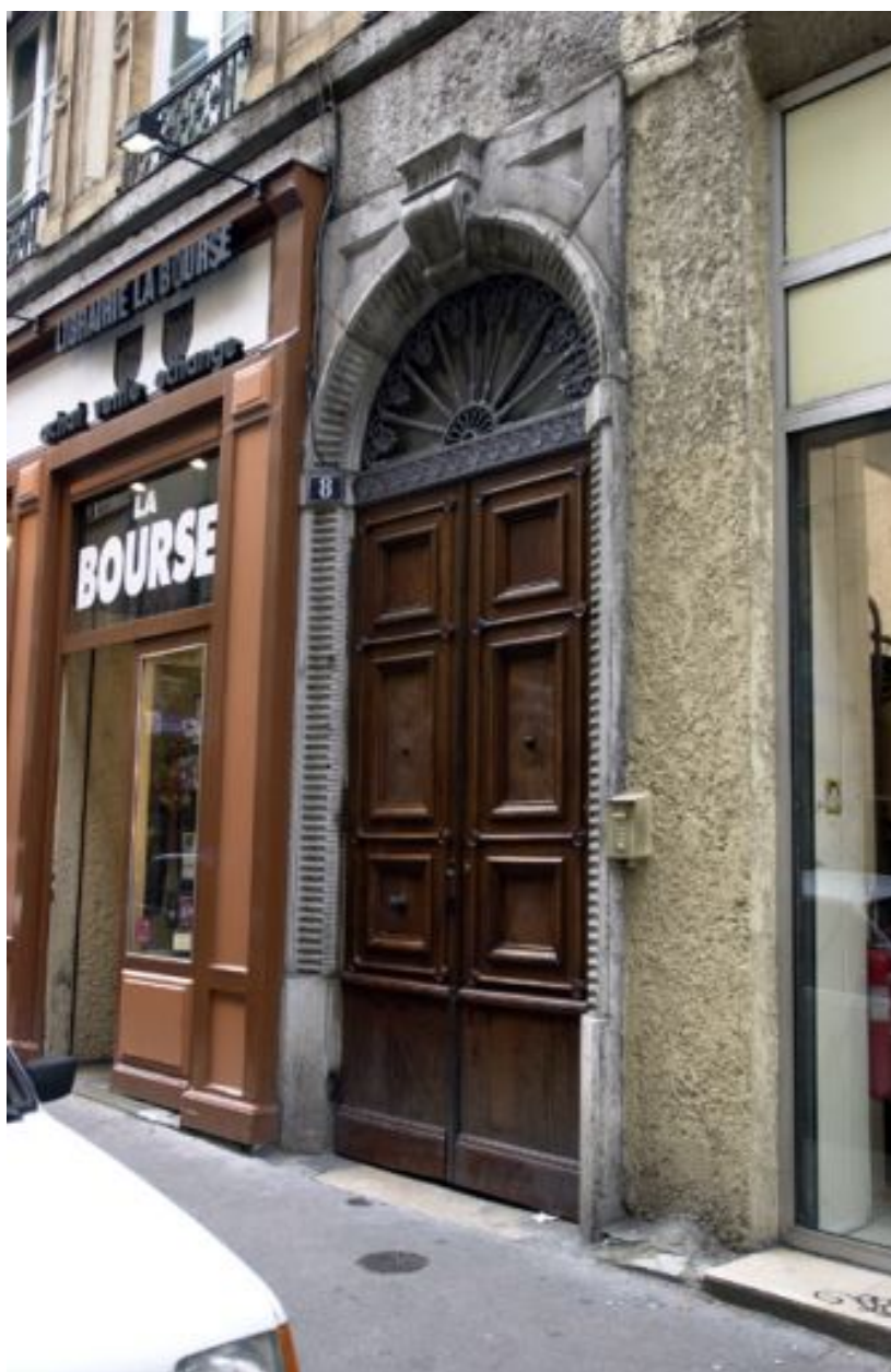
Bâtiment 1, façade sur la rue Lanterne, porte
