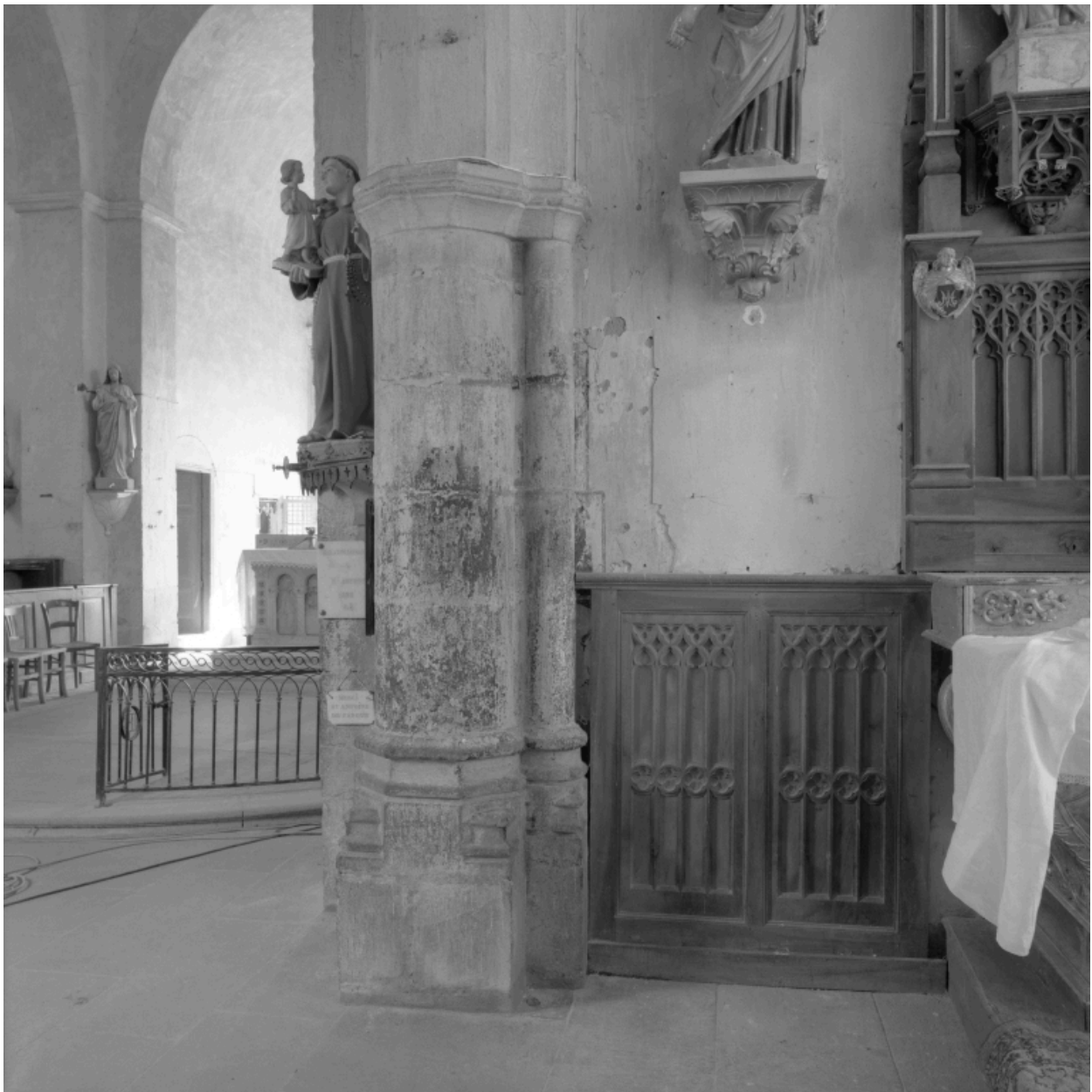
Partie basse du pilier sud à l'entrée du choeur.
