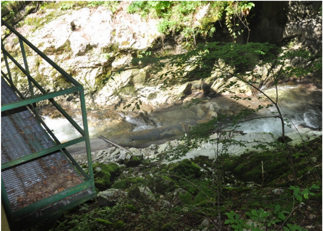
Détail du canal de fuite
